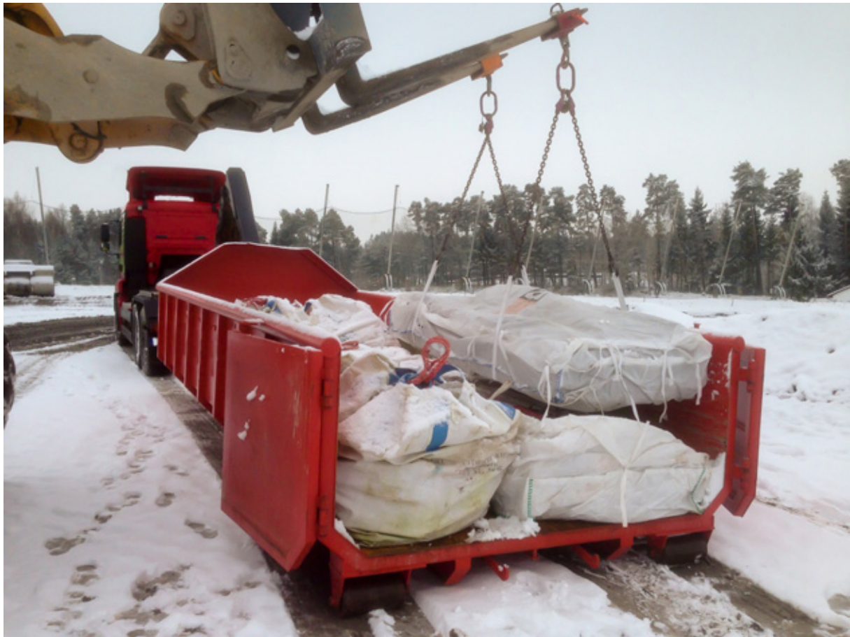
Entladen von Platten-Big Bags mit unzerbrochenen Wellzementplatten
